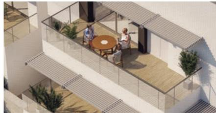
Barandilla con vidrio de seguridad montado sobre estructura de acero.
