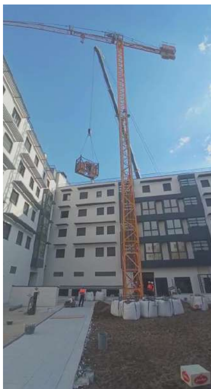
Traslado del arco desde el exterior al interior de la manzana
